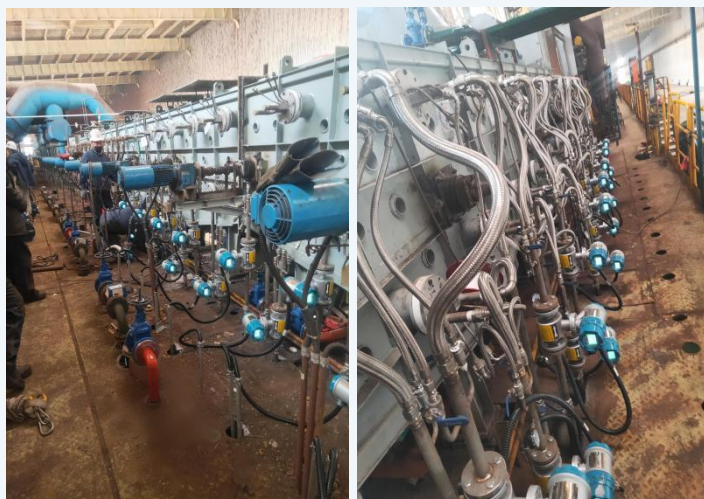
鞍钢硅钢常化酸洗气雾喷淋安装现场
