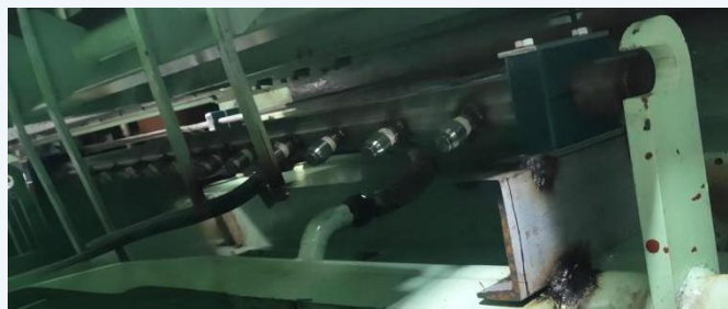
空气喷嘴吹扫梁现场
