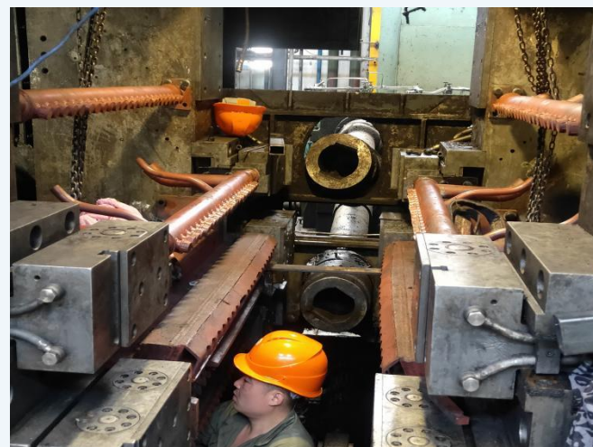
汇鑫板业六辊轧辊喷梁安装现场
