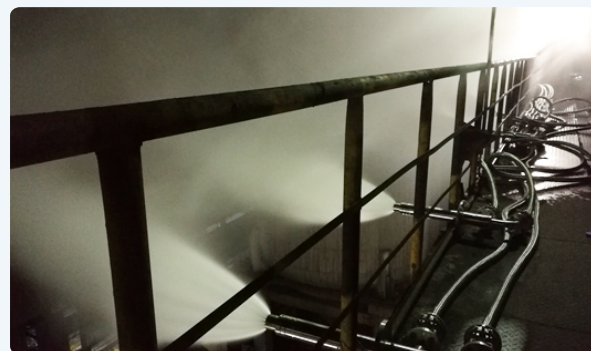
喷枪安装现场调试
