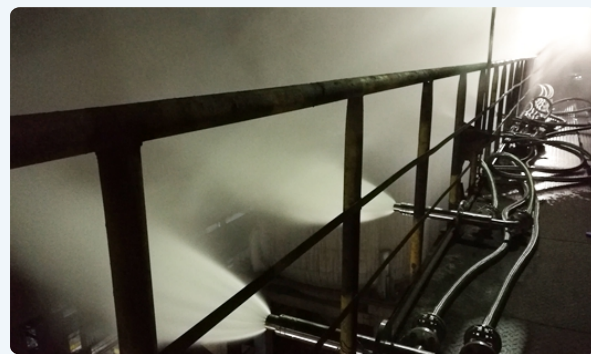
喷枪安装现场调试
