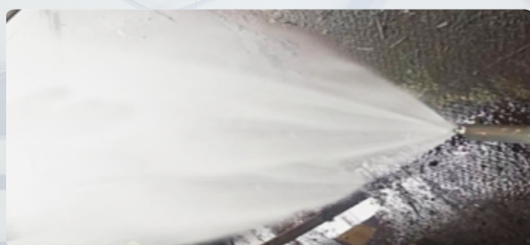
高炉炉顶打水安装现场调试
