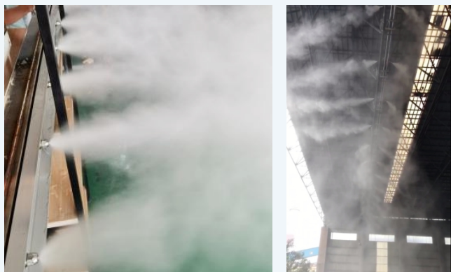
料场厂房现场安装调试
