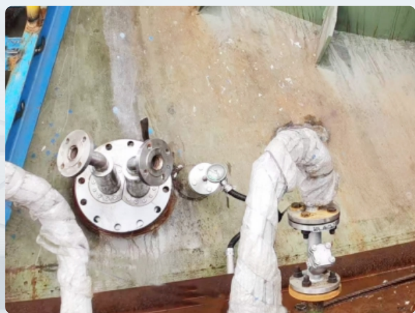
高炉炉顶打水安装现场
