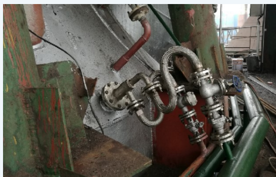
马钢炉顶打水枪安装现场
