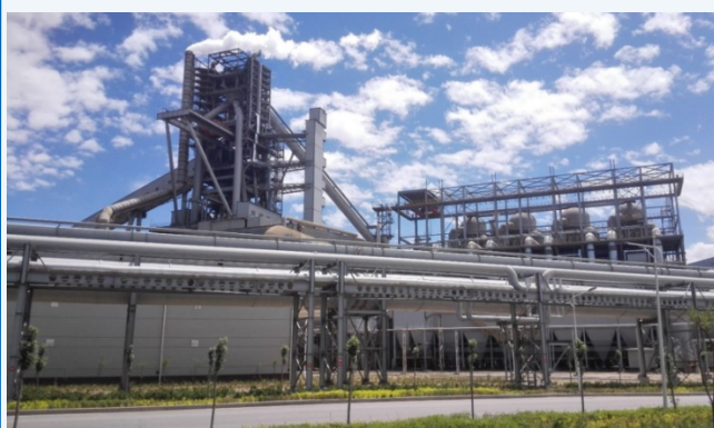
包钢新体系炉顶打水安装现场
