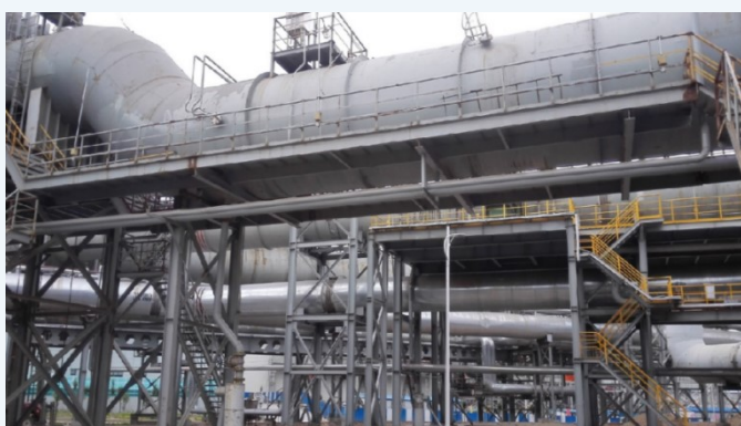
包钢烟气降温装置安装现场
