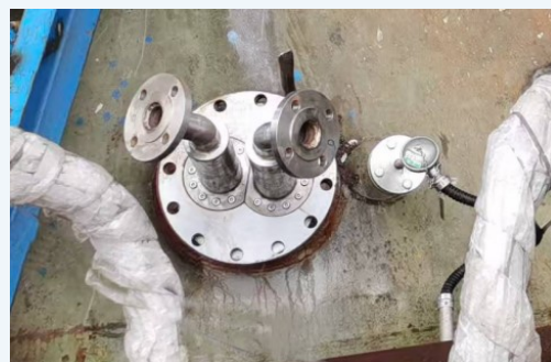
马钢安装现场
