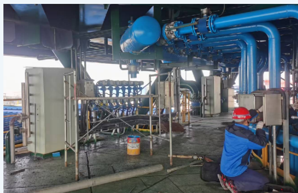
中天精品钢炉顶打水装置安装现场
