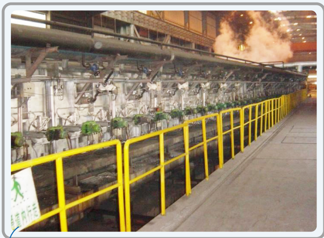
● CSP加热炉燃烧器生产现场 宝山钢铁股份有限公司
