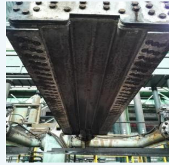
均匀快冷集管安装现场
