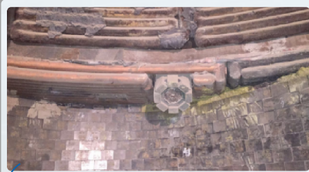
康卡斯特多功能氧枪水冷盒 马钢110吨电炉现场安装
