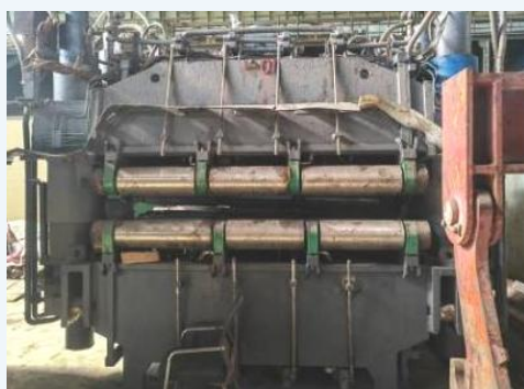
武钢板坯喷淋安装现场
