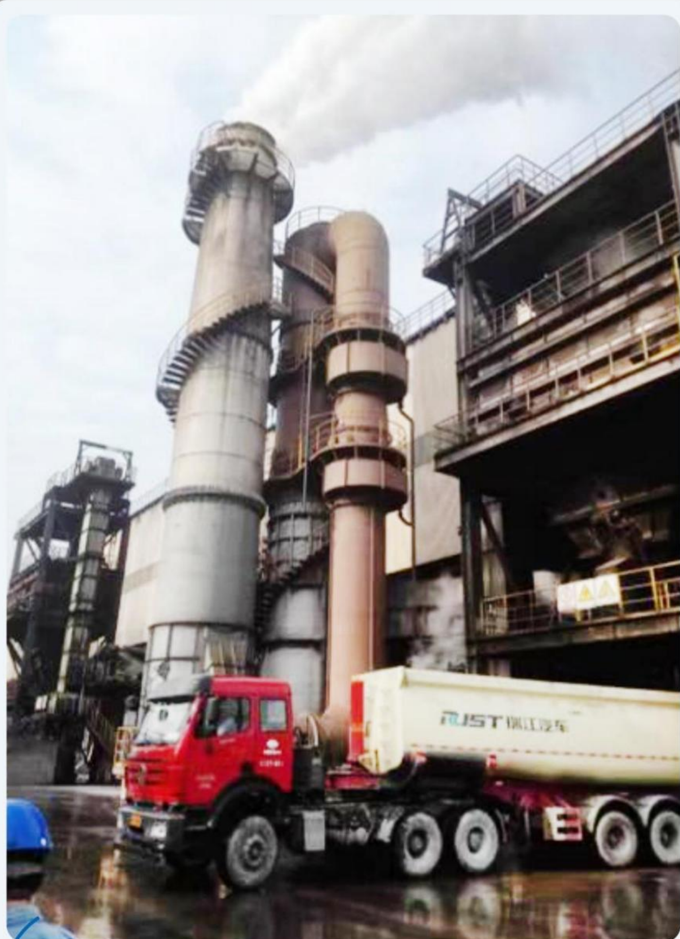
● 宝钢二炼钢渣处理 4#渣处理湿式变流除尘系统
